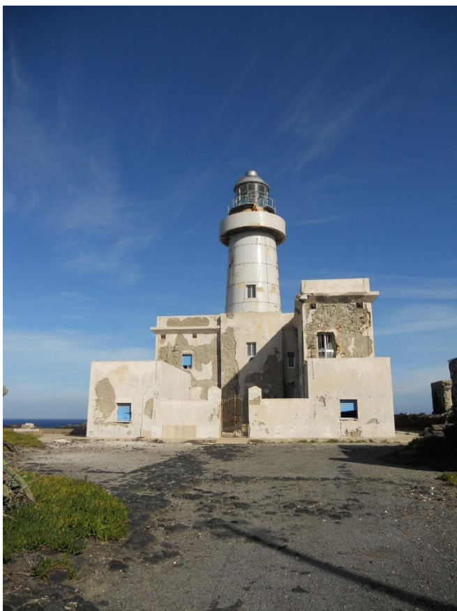
VISTA ANTERIORE DEL CORPO PRINCIPALE
