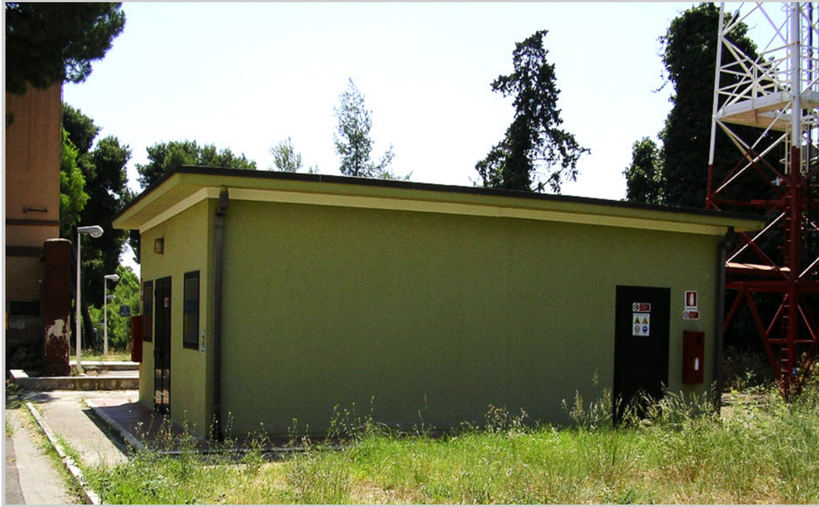
PG 138 – Manufatto a servizio del traliccio
