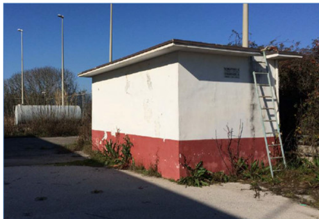
– fabbricato G - facciata sud-est
