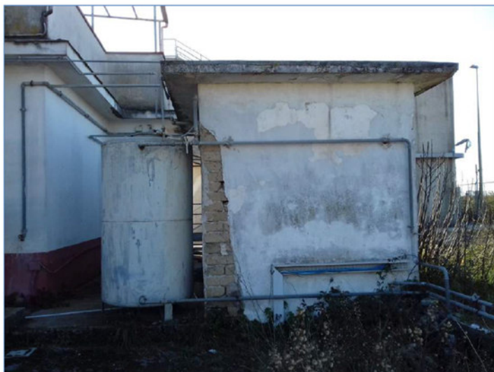
– fabbricato I – facciata nord
