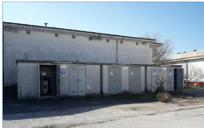
– fabbricato H – facciata nord
