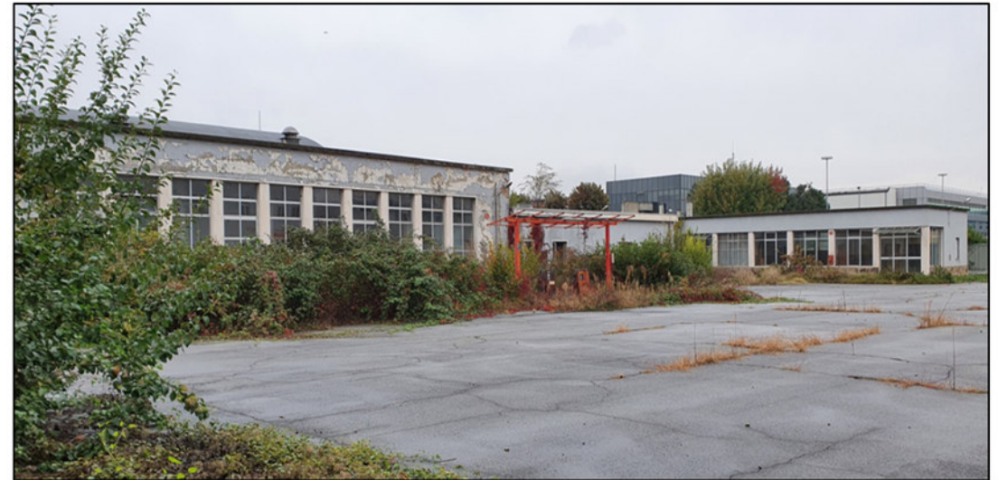
Fabbricato n. 7B di PG
