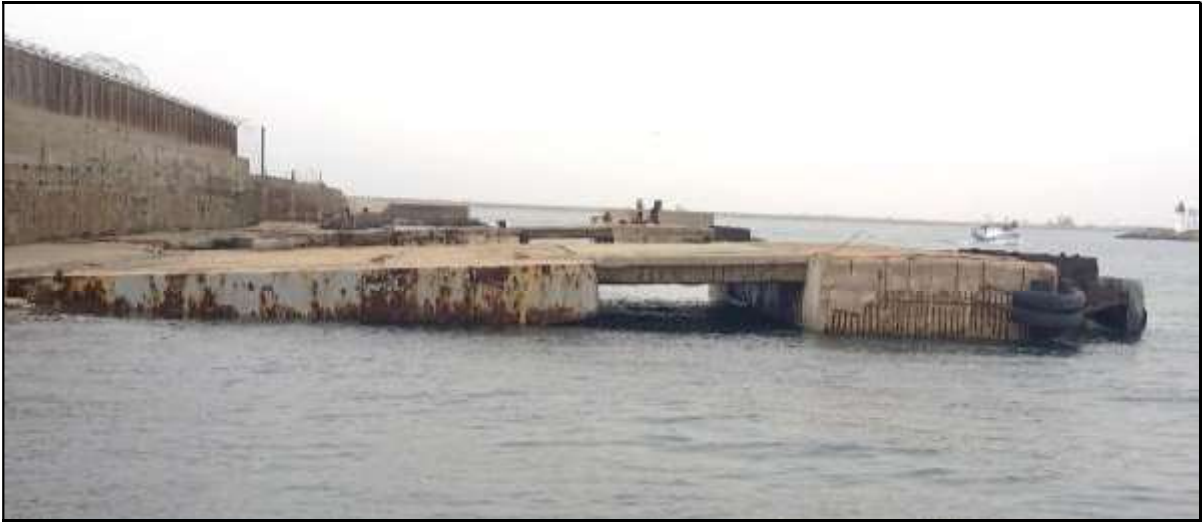
Figura 5 – Vista laterale sporgenti
